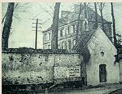
Château Prioux, Casino des officiers relié au central téléphonique
