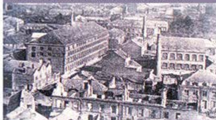
Maisons ruinées rue Marliot. Au 2 ème plan les ateliers Toffin et Bêlot récemment démolis
