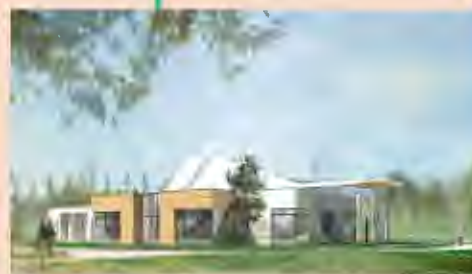
Communauté de Communes du Caudrésis-Catésis: construction d'un crématorium
