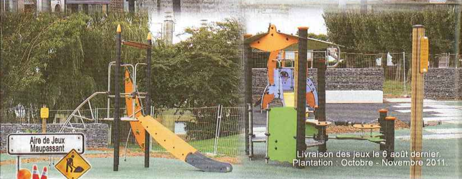
1 ère phase de travaux achevée. Prochamment lancement de la 2 ème phase : Centre Ville et quartiers périphériques.
