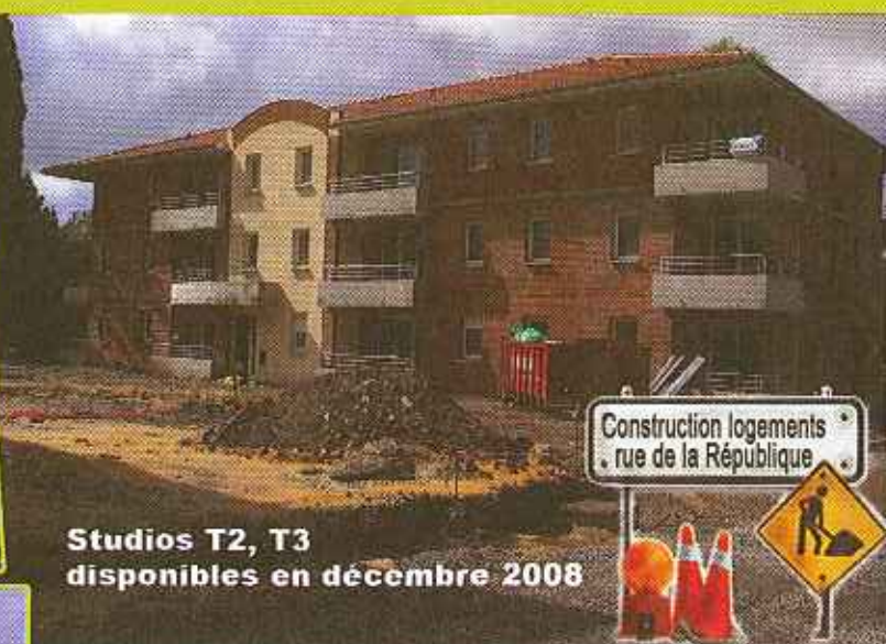
Construction logements Audencourt
