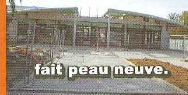
Grand Projet de rénovation : Le collège PREVERT
