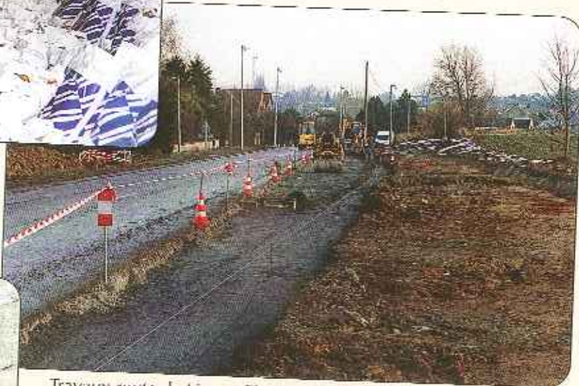
Travaux route de Ligny : Elargissement de la voie à l'entrée de Caudry et réalisation de pistes cyclables.
