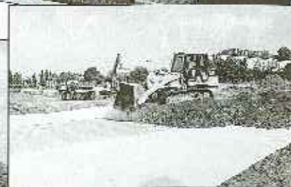
Chantier Lycée HQE
