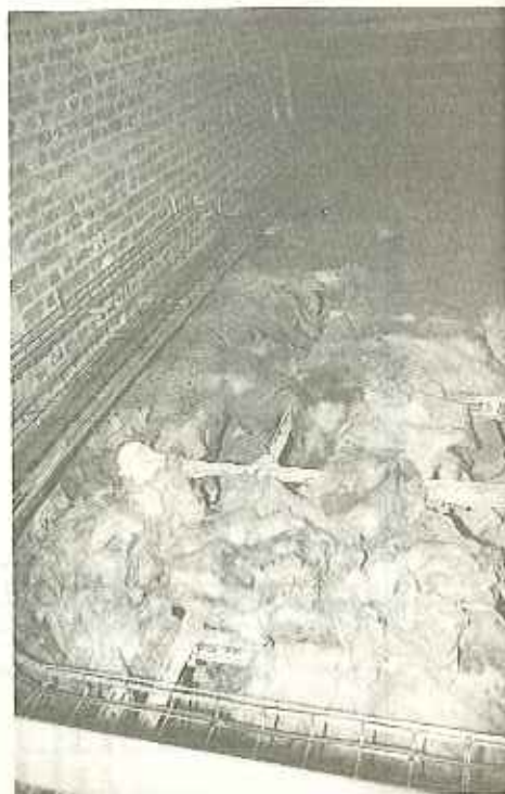
Salle des Fêtes : Isolation toiture
