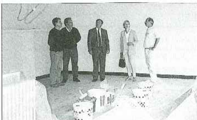
Visite du chantier - Ecole Maternelle Jules Ferry
