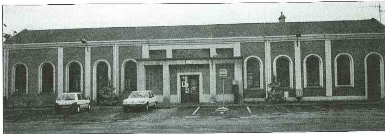
GARE SNCF - CAUDRY
